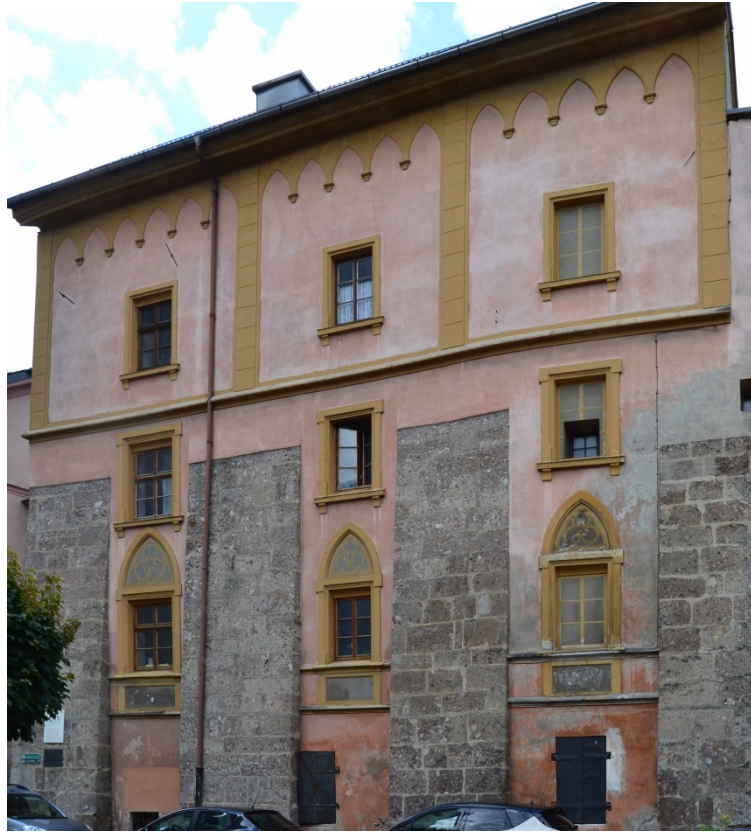
Abbildung 5 – Innsbruck, Domplatz 1, Stützpfeiler.
