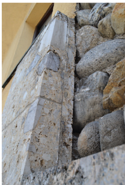
Abbildung 7 – Innsbruck, Marktgraben 13. Neuzeitlicher Stützpfeiler an mittelalterlicher Stadtmauer.
