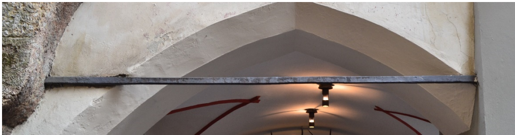
Abbildung 9 – Innsbruck, Herzog-Friedrich-Str. 12 und 15. Eisenstangen bzw. -verstärkungen, Laubengang.
