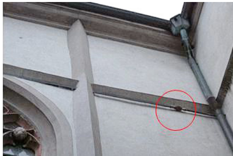
Abbildung 3: Eine Eisenstrebe entlang der Nord-Fassade der Salvatorkirche (siehe Stadtplan, Nr. 16) sowie Detailzeichnung des Verbindungsstücks einer Schleuder
