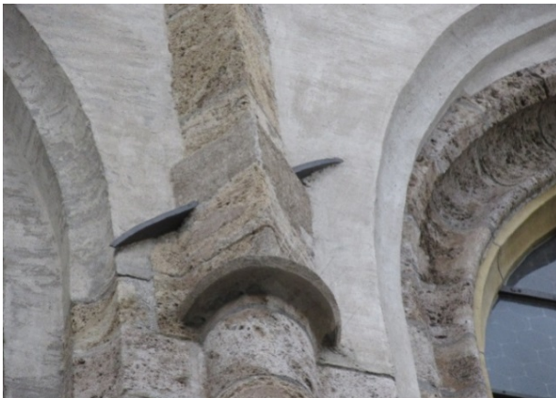
Abbildung 1: St. Nikolaus. Eisenschleuder an der Südseite.
