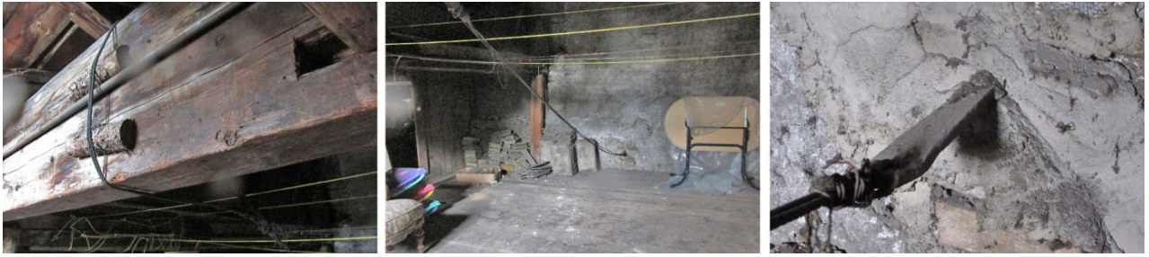
Abbildung 5: Befestigung einer Metallschleuder am Dachboden des Wohnhauses Salzburgerstraße13 in Hall i. T.
