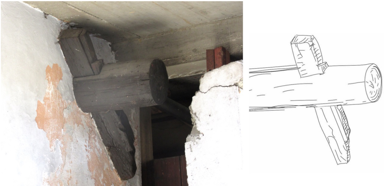
Abbildung 6: Die Holzschleuder von der Krippgasse Nr.3 in Hall i. T., Ansicht von Süden (siehe Stadtplan, Nr. 17) sowie deren Umzeichnung.
