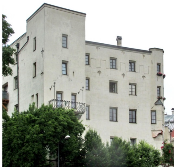
Abbildung 8: Der Ansitz Rainegg, fotografiert vor 1904 und heute, mit den kunstvoll kreierten Eisenschleudern auf der Süd- und Westfassade (siehe Stadtplan, Nr. 12, sowie Tafel 1, Typ 3, 11; 12 ).
