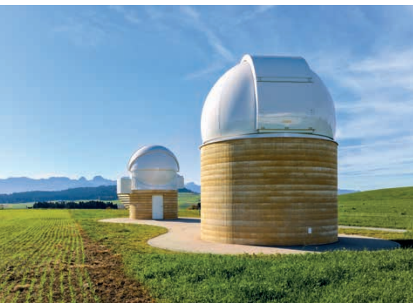
Sternwarte Zimmerwald: Die beiden neuen, futuristisch anmutenden Kuppelbauten loten präzise den Abstand zur bestehenden Anlage aus. Die Stampfbeton-Ummantelung kontrastiert farblich mit den beiden Kuppeln (links oben). Die Teleskope stehen auf einem unabhängigen Sockel, damit die Gebäudeschwingungen die Messungen nicht beeinträchtigen (rechts). Fotos Michael Peuckert
