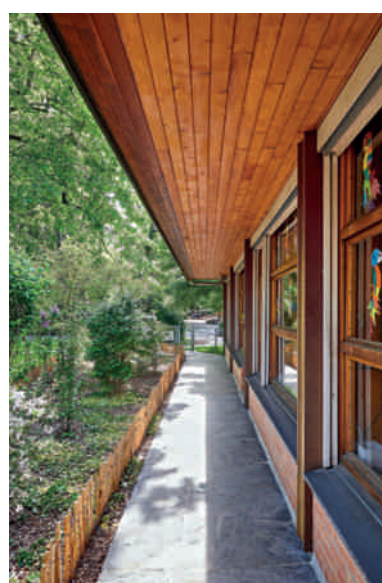
Bâtiment A (1952-53), école enfantine, façade sud (en haut), façade sud vue en direction de l'est (à gauche) et façade sud vue en direction de l'ouest (à droite). Les salles de classe sont éclairées naturellement grâce à de grandes baies vitrées qui laissent entrer la lumière du soleil. L'intensité de cette dernière est contrôlée par l'action commune de la végétation et des avant-toits qui empêchent les élèves d'être éblouis. Photos Dirk Weiss
