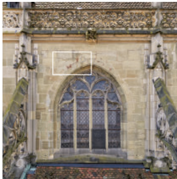
Von Ersatzmassnahmen verschont, ist das Obergadenfenster 90 an der Südseite des Chores eine bereichende Quelle der Baugeschichte. Der mittelalterliche Bestand zeigt Spuren verschiedener Restaurierungsphasen (unten: Gesamtansicht, oben: Detailausschnitt, 2016). © Berner Münster-Stiftung
