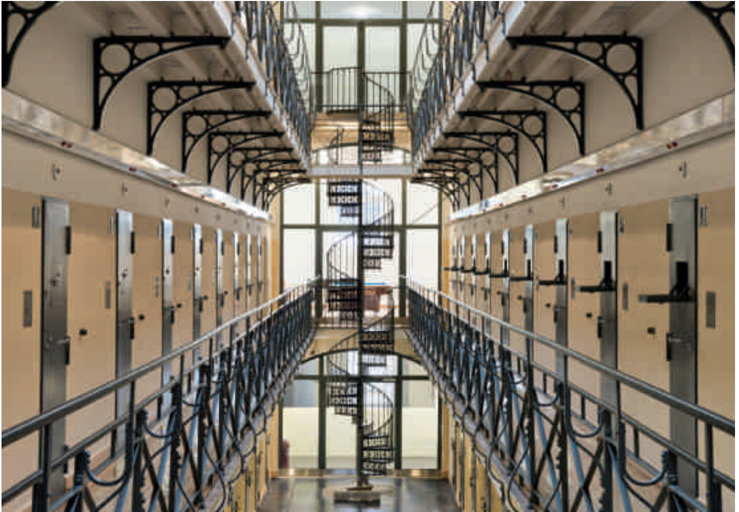
Abb. 9 Blick in einen Zellenflügel mit den von Konsolen gestützten Galerien. Foto IMAG (René Rötheli), 2016
