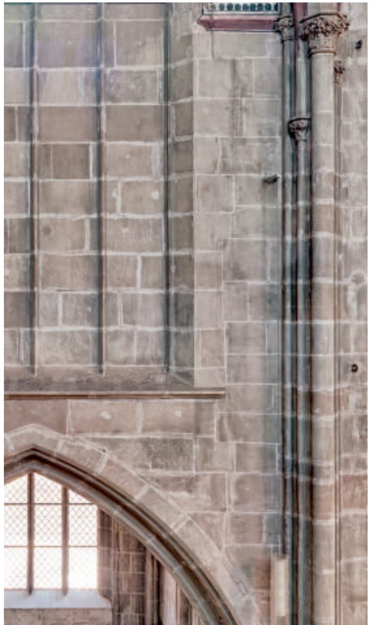
Abb. 2 Baunaht mit deutlichen Störungen im Mauergefüge, die weissen Fugen wurden später aufgemalt und entsprechen nicht überall dem originalen Fugenverlauf. Foto Nick Brändli / © Berner Münster-Stiftung
