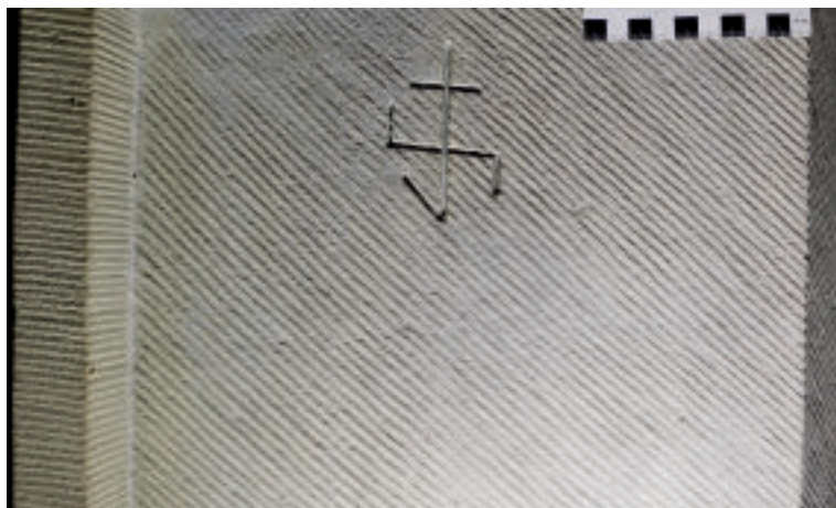
Abb. 4 Im Chorpolygon verbauter Steinquader mit einer fein gebeilten Oberfläche, darauf ein Steinmetzzeichen. Foto Berner Münster-Stiftung
