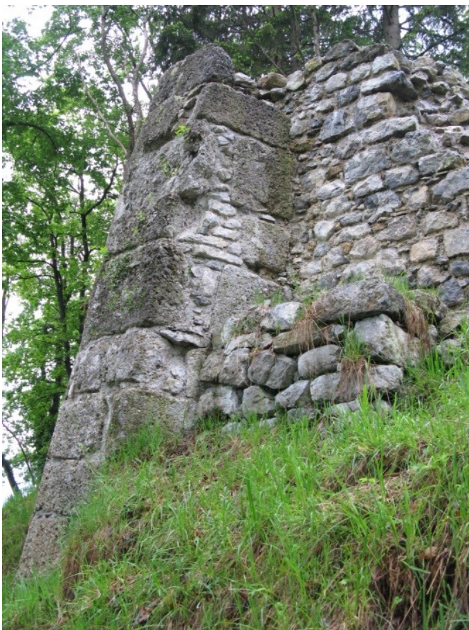
Abb. 4: Schloss Thaur bei Hall in Tirol. An die Ostmauer in maximilianischer Zeit angesetzte Pfeiler aus Nagelfluh. Foto: Stefan Fiechtner, Innsbruck.
