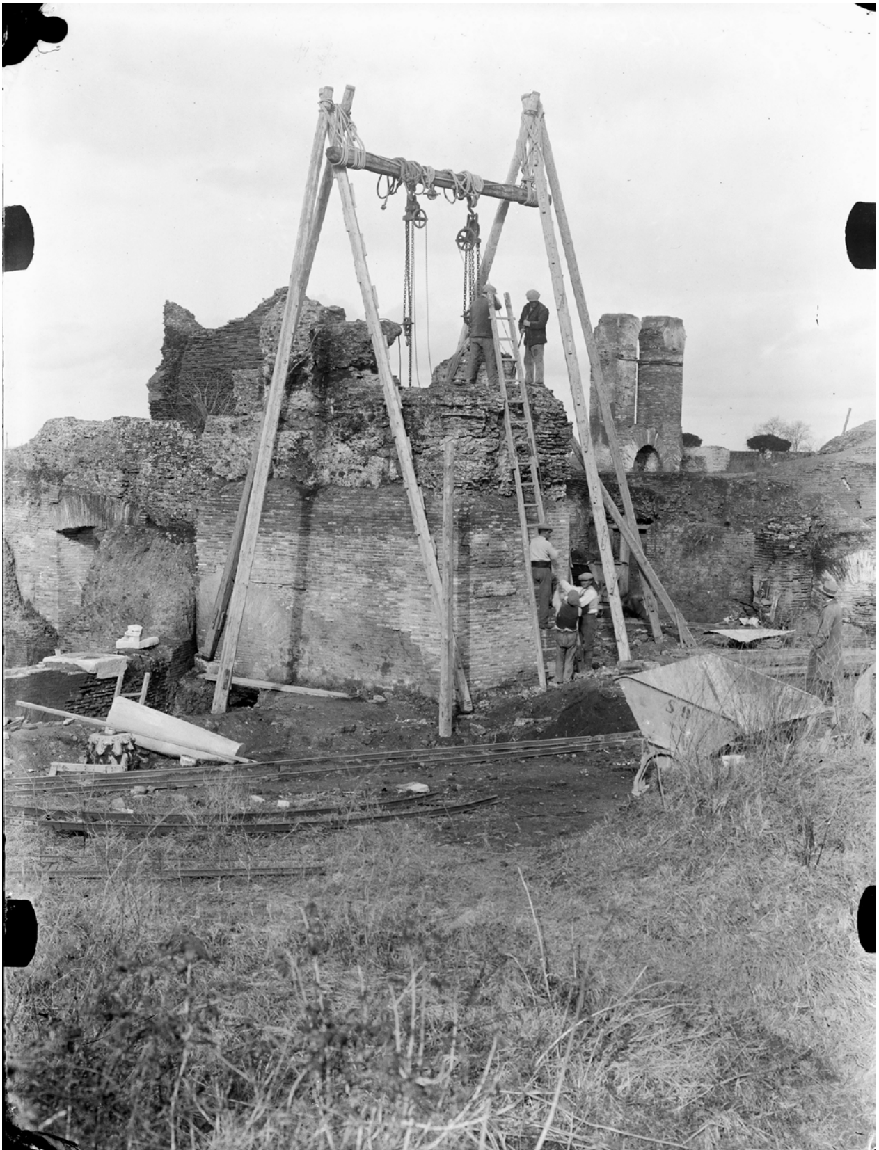
Abbildung 9: Forumstherme (1928). Einige Einstürze wurden in kleinen Fragmenten abgeschnitten und wieder gehoben. Das war möglich, weil der Mörtel noch von hoher Qualität war ( Opus Cementicium ), C1260, Fotoarchiv, PAOA.
