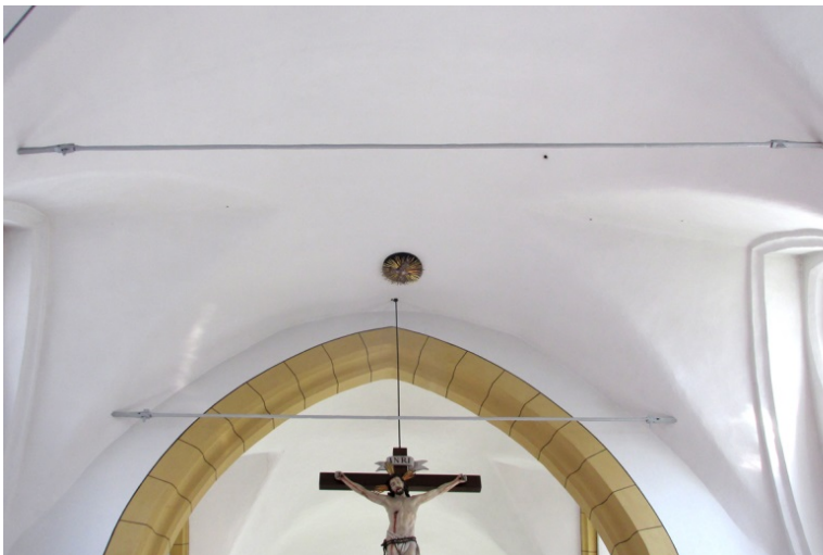
Abbildung 4: Die Verbindungsanker der Pfarrkirche von Volders. Die Umzeichnung zeigt das Stecksystem einer Schleuder mittels eines Keils.
