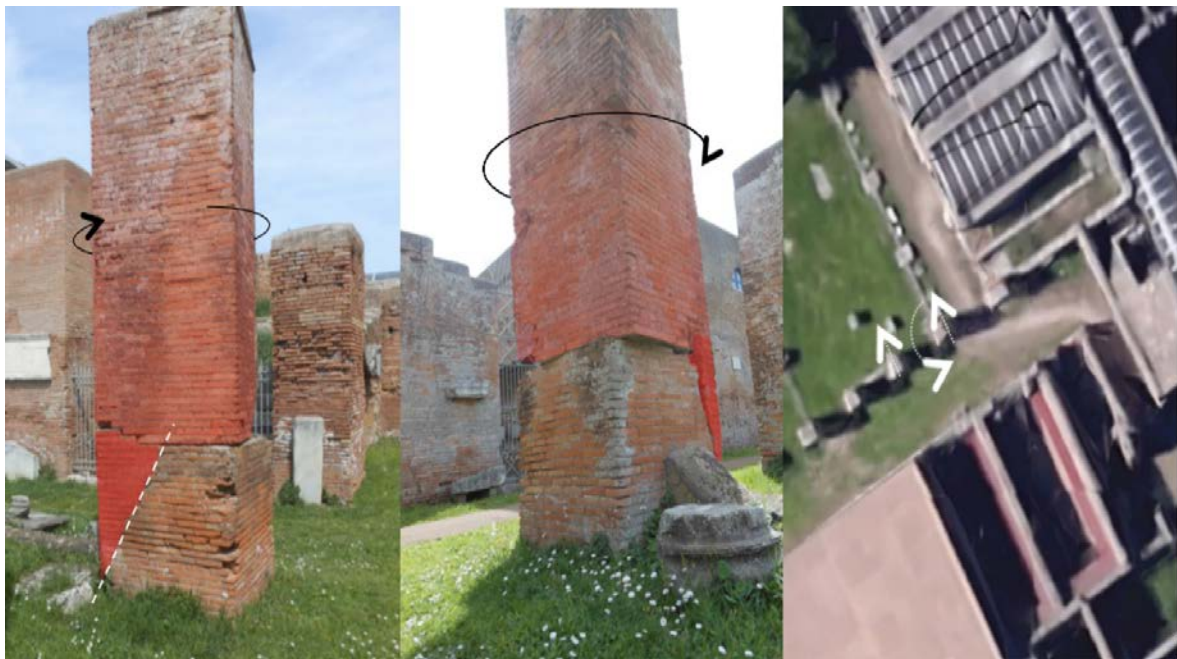
Abbildung 5: Bruchzone aufgrund der Verdrehung des Pilasters im oberen Bereich (Piccolo Mercato)
