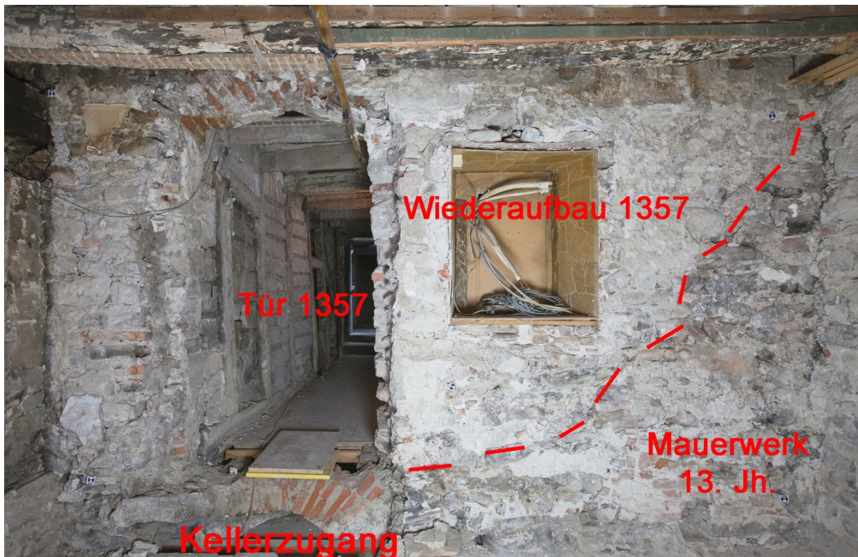
Abbildung 11: Basel, Haus „zum Waldshut“. Rückseitiger Steinbau mit Brandspuren (13. Jh.) und Wiederaufbau 1357.
