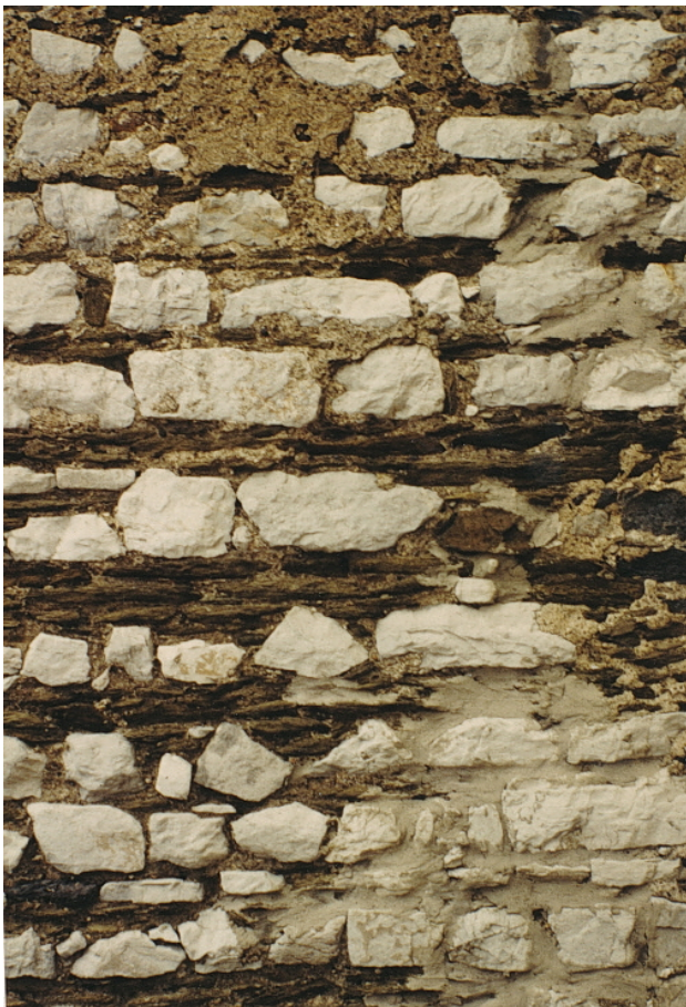
Abbildung 6: Mauerwerk in Limburg um 1250: Lagen von Kalkstein (weiß) wechseln sich mit Schalstein (grün) ab.
