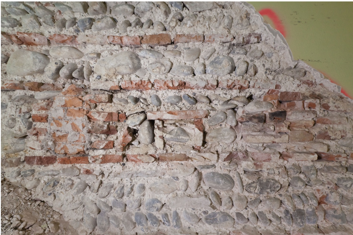
Abbildung 25: Basel, Steinenvorstadt 42. Typisches Basler Mauerwerk nach dem Beben von 1356. Nördliche Brandmauer aus Mischmauerwerk (Wacken und Backsteine) mit Auflagern für Gerüsthölzer und Balken, errichtet vor 1426.
