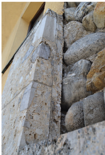
Abbildung 7 – Innsbruck, Marktgraben 13. Neuzeitlicher Stützpfeiler an mittelalterlicher Stadtmauer.
