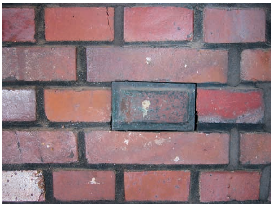
Abb. 1 Krefeld (D), Haus Esters, Ludwig Mies van der Rohe, 1927–1930: Backsteinimitation aus Blech als Verblendung über einem Klingelknopf zum Rufen des Personals. Foto Melchior Fischli, 2004
