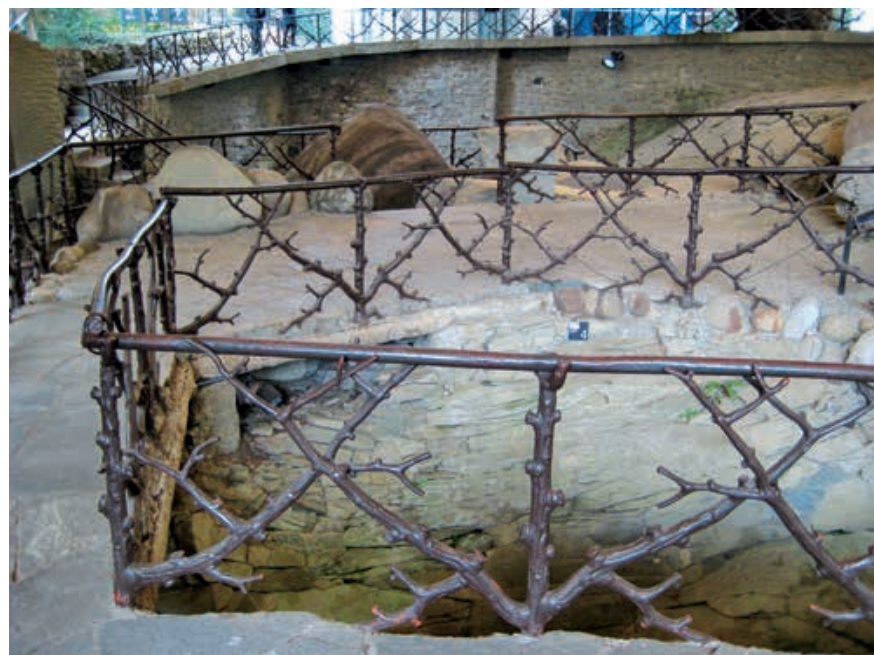
Abb.3 Rüttenen bei Solothurn, Waldpark Wengistein, drahtarmiertes Betongeländer als Knüppelholzimitation, 1908. Foto M.F., 2018
