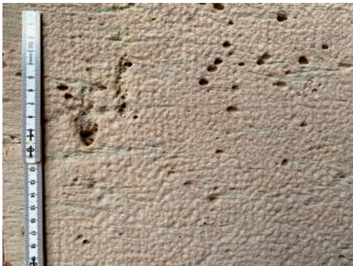
Abb. 2a Besonders auffällig ist ein hellgrauer bis weisslicher, feinkörniger, oft grünlich gefaselter und bisweilen durch kleine, kreisrunde Löcher geprägter Flasersandstein, der die romanischen Bauteile an der Westfassade des Georgs- und teilweise des Martinsturms kennzeichnet. Foto Bianca Burkhardt, 2019
