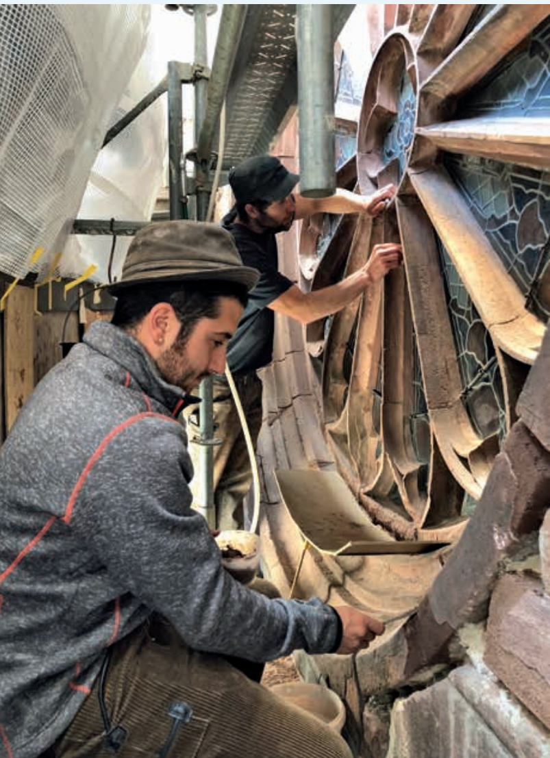
Chorbaustelle. Steinhauer Jérôme Lorenz während Antragungen in Steinergänzungsmörtel. Foto Basler Münsterbauhütte
