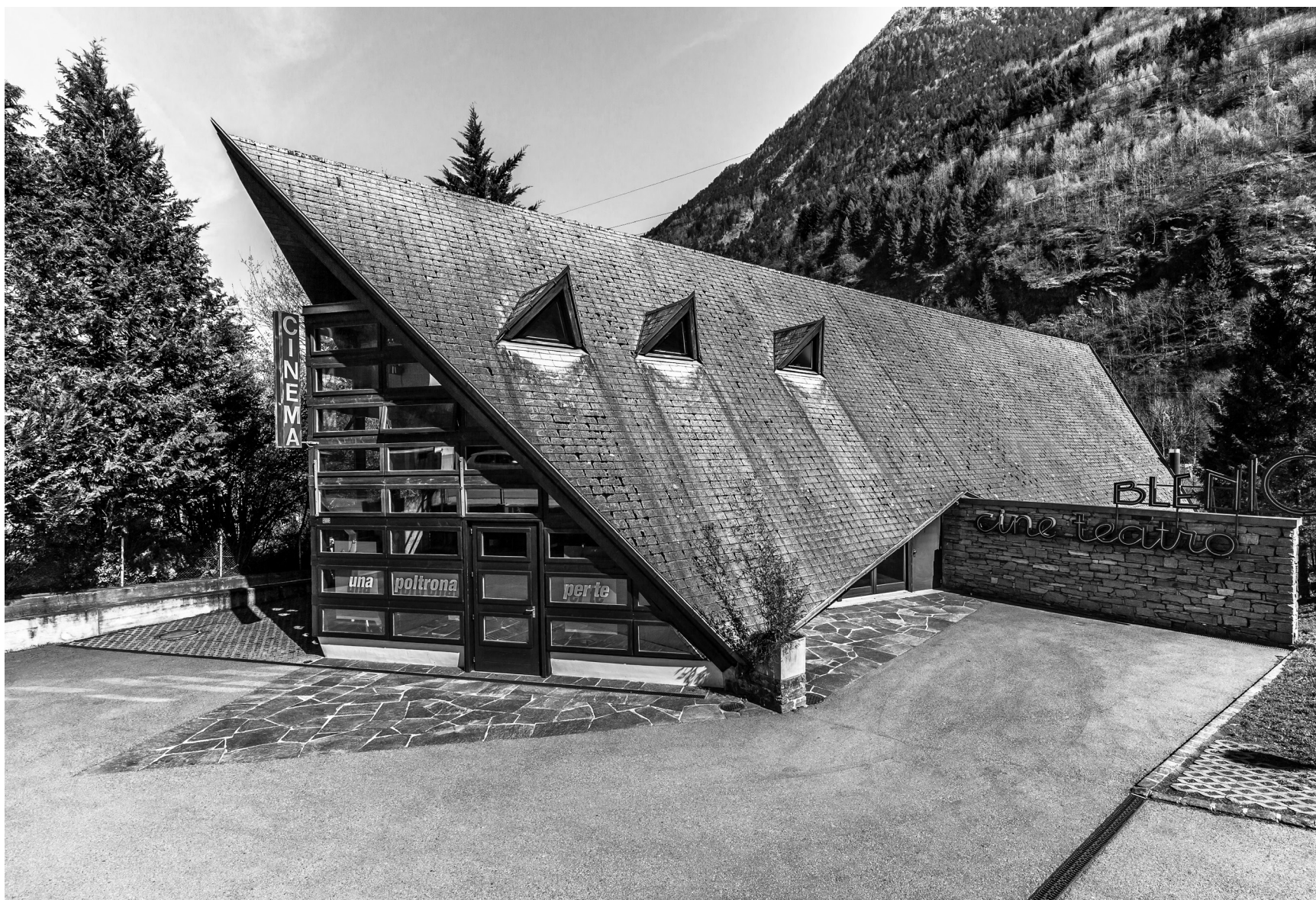
Fig.2 Vista del fianco sud. La fotografia evidenzia la linea orizzontale del colmo e la geometria complessa delle falde del tetto.
