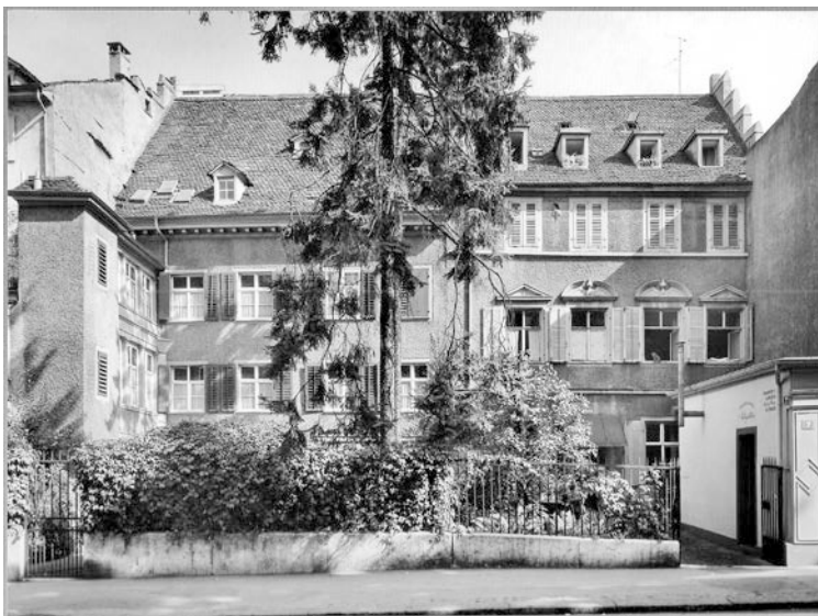
Abbildung 7: Basel, Kohlerhof (Petersgraben 5–7). Ansicht des Hauptgebäudes vom ehemaligen Stadtgraben aus. Linke, nördliche Hälfte um 1293 erbaut, 1364 neues Dachwerk und Erweiterung um südliche Hälfte. Umbau und Fassadenerneuerung nach Hausteilung und Abbruch der Stadtmauer.
