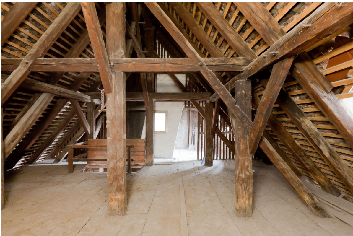
Abbildung 9: Basel, Kohlerhof. Dachwerk von 1364, Firstständer und stehender Stuhl im zweiten Dachgeschoss.
