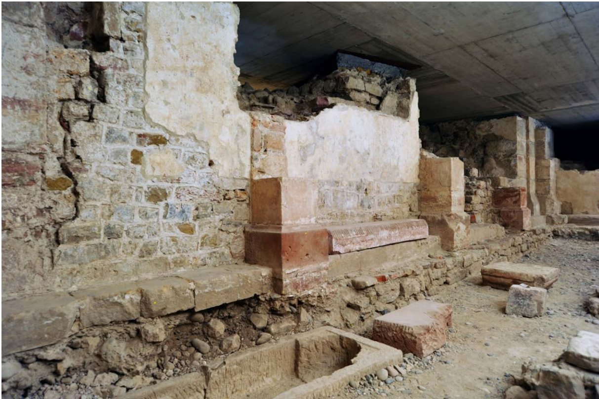
Abbildung 17: Basel, Münster. Südseite der Vierungskrypta. Drei der nach dem Erdbeben von 1356 an den Wandseiten eingefügten spätgotischen Wandpfeiler. Die Fundament- und Sockelzone sowie die Blendmauer mit den erhöhten Fugengraten stammen aus frühromanischer Zeit.
