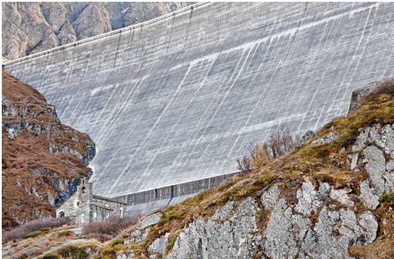
Die Staumauer Grande Dixence (© GSK, Photo Michael Peuckert).
