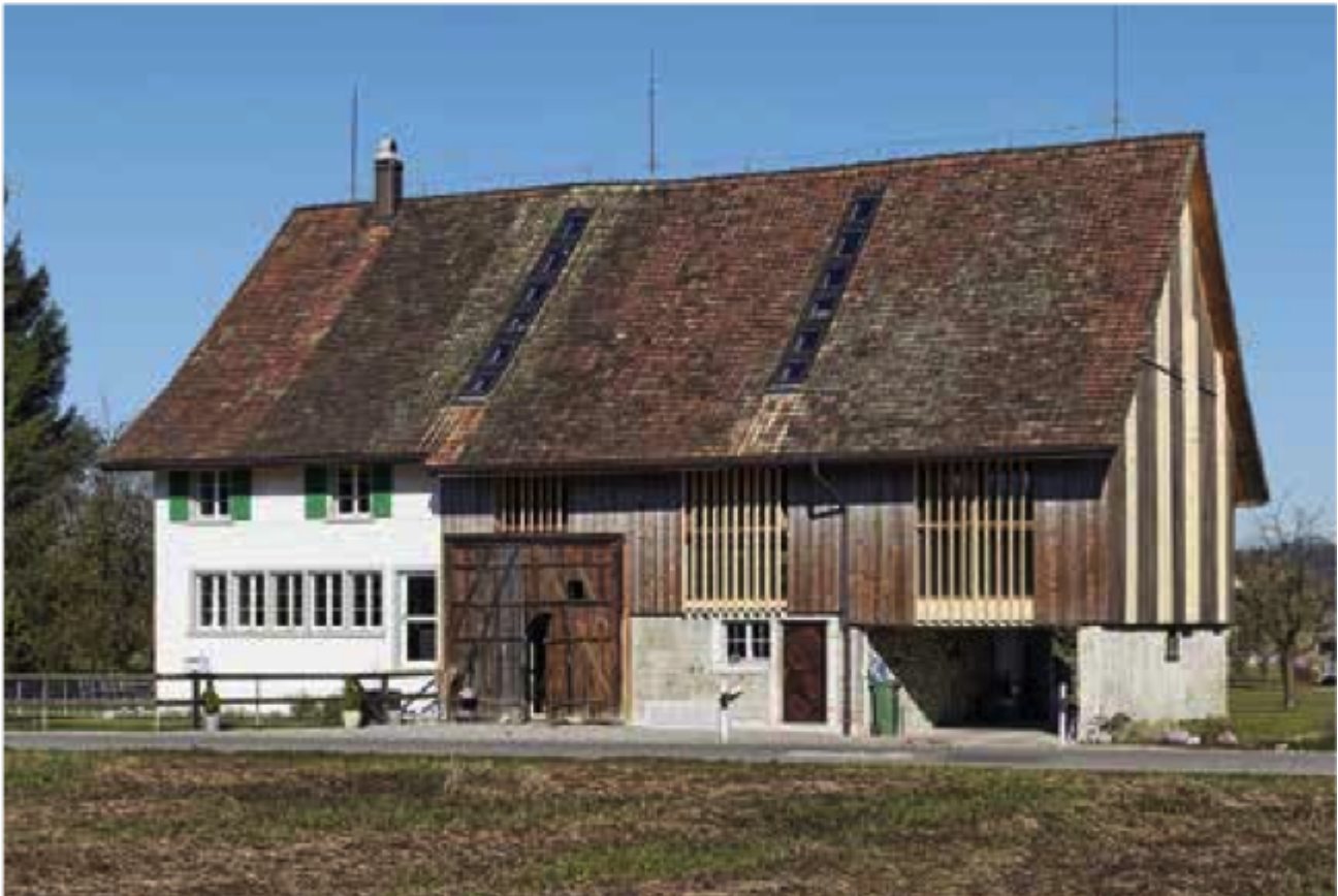
Abb. 4: Wohnraum statt Heuboden in Bisikon dank grossen Fenstern hinter Lamellen. Die von Theo Wälty erfundenen Lichtbänder im Dach nehmen die von den Ziegeln vorgegebene vertikale Streifung auf. Foto Nick Brändli
