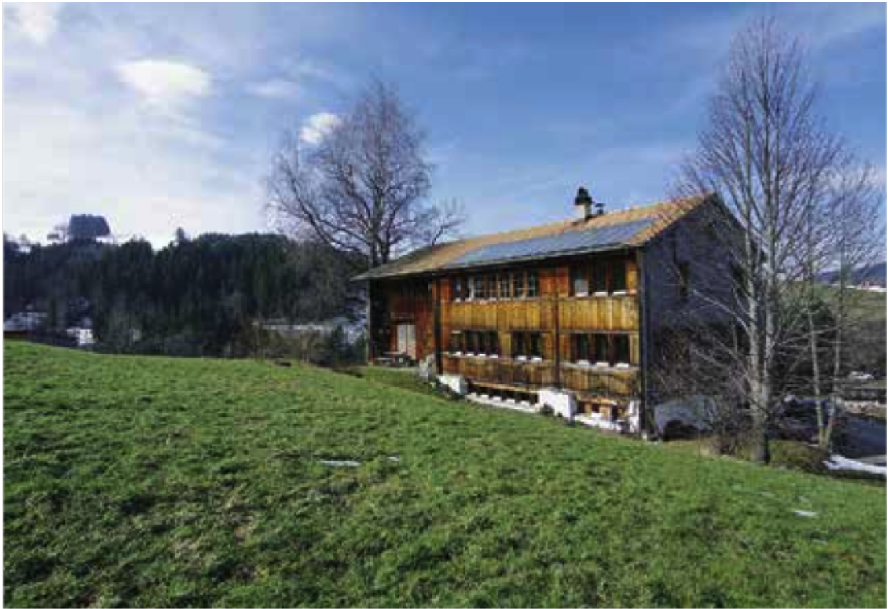
Abb. 8: Appenzellerhaus von 1993 in der Nähe von Trogen. Die von Ernst Sturzenegger in der Achse der Fassadenfenster platzierten thermischen Kollektoren gehören zur Gestalt des Hauses. Foto Moritz Flury-Rova
