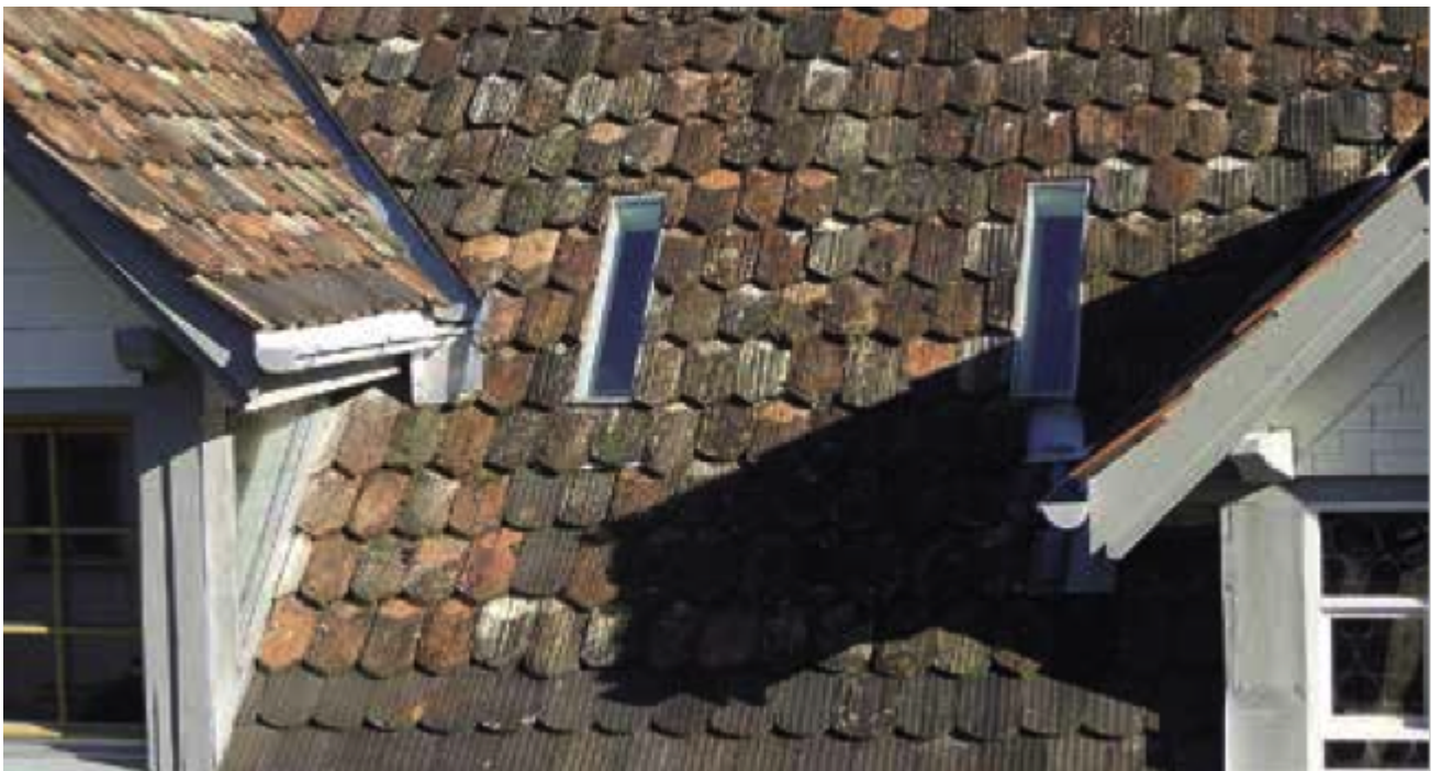
Abb. 5: So feine Schlitz e verträgt auch ein Altstadtdach in Lichten- steig. Ohne Schliessmechanismus und Sonnenschutz verschwinden diese von Paul Rutz entwickelten Fenster in
