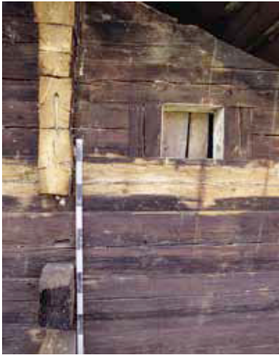
Abb. 2 Haus Unterblacki, Ansicht an das Giebfeld der noch nicht renovierten Hauptfassade: Unter dem originalen Heiterloch ist der Fenstergurtbalken mit farbllichem Negativ eines abgeheilten Zierfrieses erkennbar. Durch das Zurücksägen der Vorstösse der Firstkammerwand wurde ein Dübel wieder sichtbar
