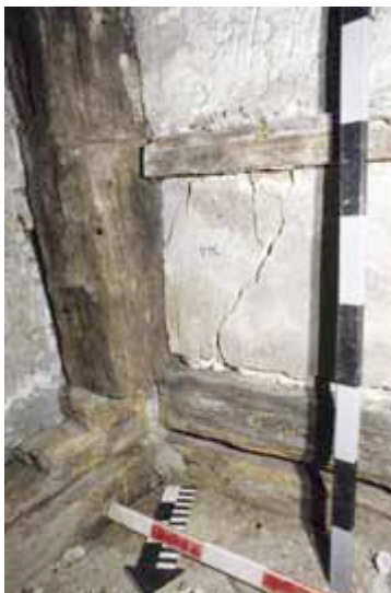
Abb. 10 Haus St.-Oswalds-Gasse 10, erstes Obergeschoss, Raum 10, Südwestecke: Der originale Ständer ist mit Fase und auslaufendem Schildchen verziert. Er ist in die südliche Aussenschwelle eingezapft, in welche die Schwelle der ehemaligen Westwand des Raumes stösst. Während die Bodenbretter unter dieser durchlaufen, sind sie in der Aussenschwelle eingefalzt. Über der Oberkante des bereits entfernten Mörtelgusses sind die Nuten zur Aufnahme der Bodenbretter sichtbar
