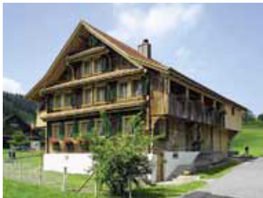
Abb. 1 Haus Unterblacki nach dem Umbau, Ansicht von Nordosten: Dank einem umsichtigen Umbaukonzept konnte die ursprüngliche Grundrissstruktur und viel von der originalen Bausubstanz bewahrt werden
