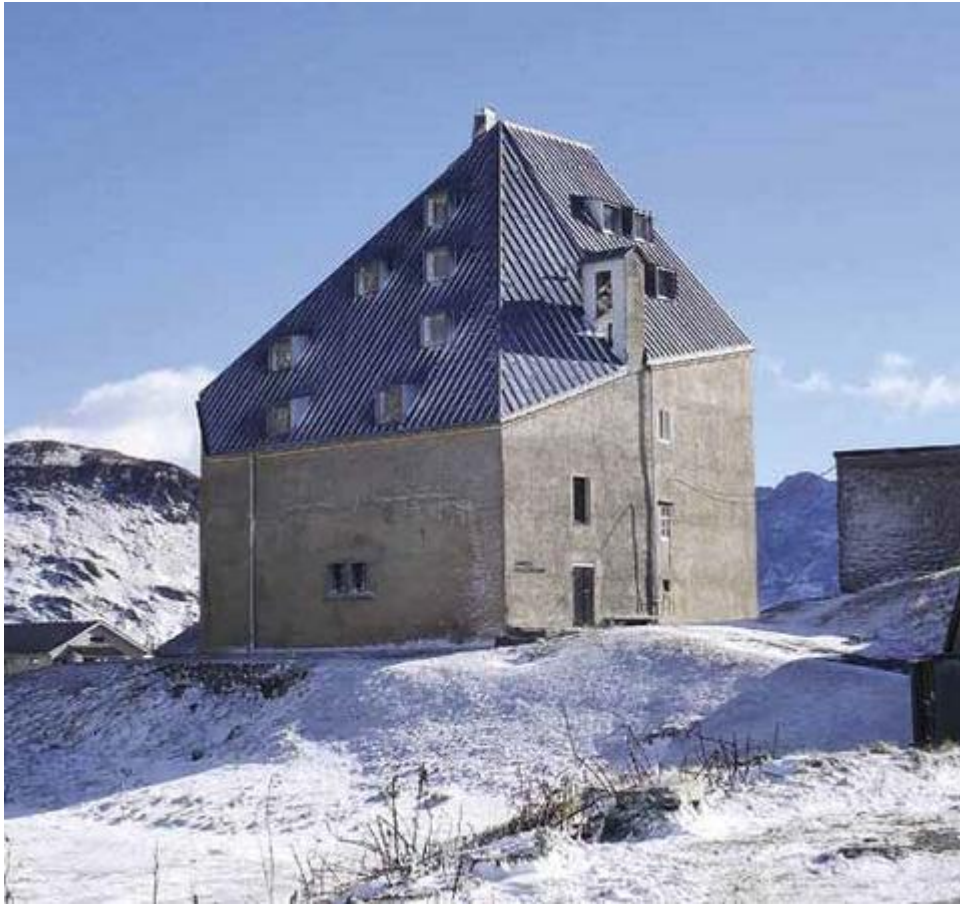
Gotthard-Hospiz: eine tragende Holzkonstruktion im Gebäudeinneren, Fassade und Treppenhaus in Massivbauweise (© GSK, Photo Michael Peuckert).
