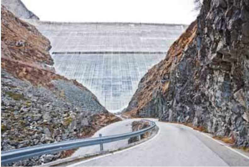
Grande Dixence: Staumauer aus 6 Millionen Tonnen Beton (© GSK, Photo Michael Peuckert).
