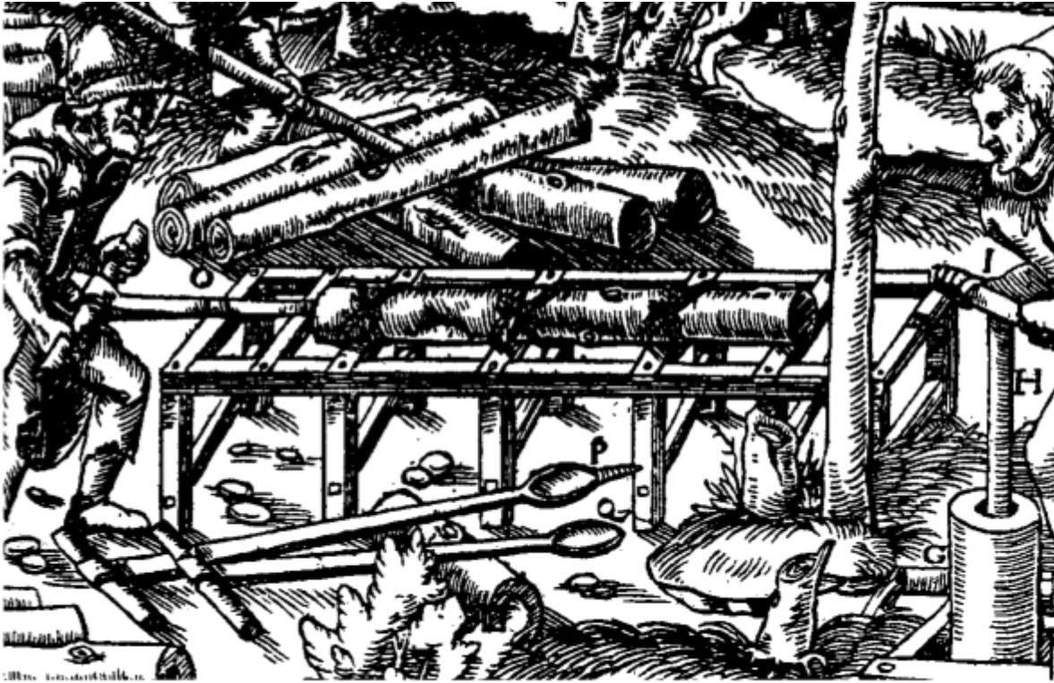
Abb. 4 Darstellung des Teuchelbohrens. Holzschnitt aus Georg Agricola 1556 (Ausschnitt)
